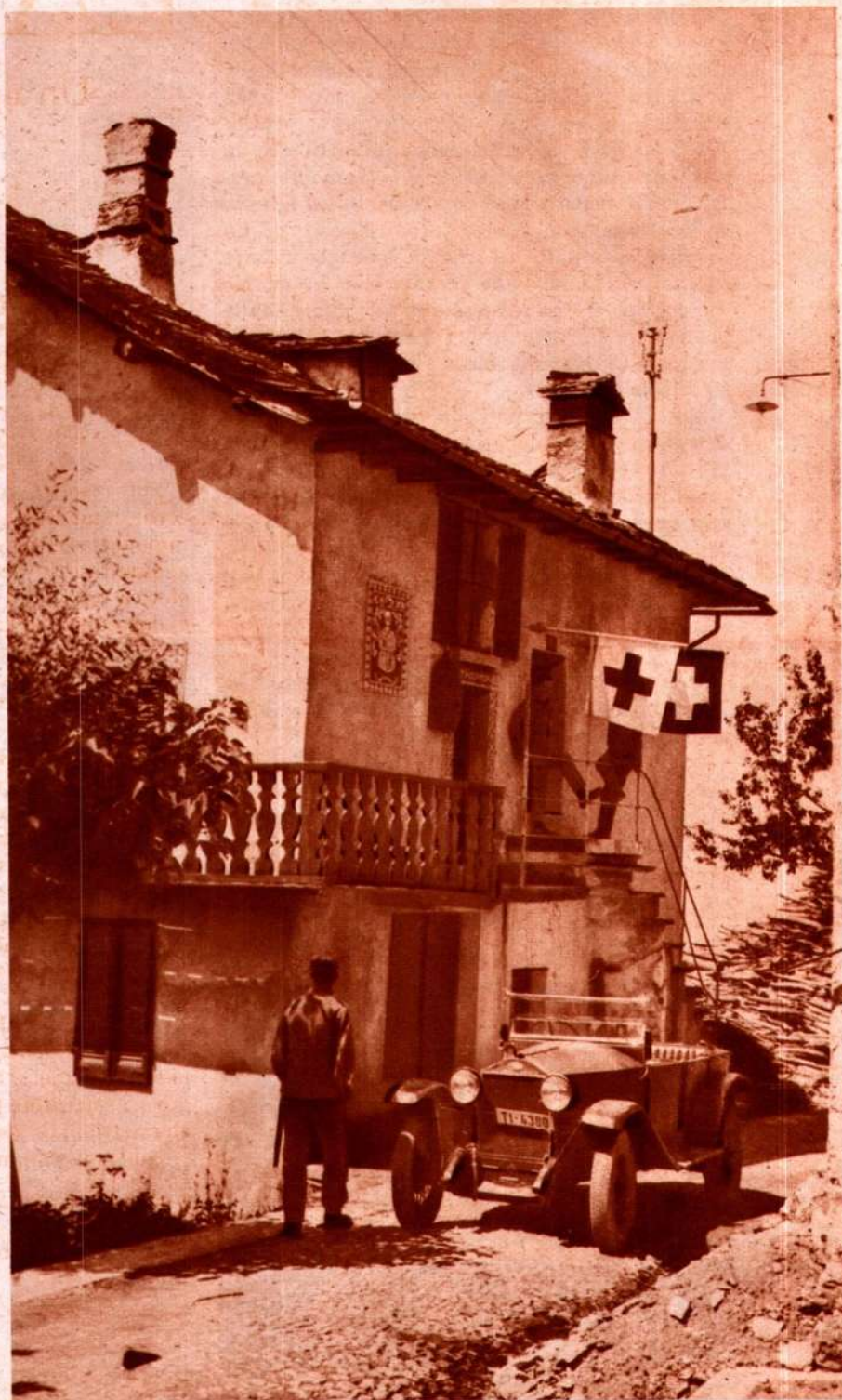
Carena. La sede degli uffici dell'ex ferriera trasformata in accantonamento militare.
