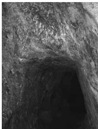
Figura 15. Tracce di lavorazione manuale sulla volta della galleria principale della Miniera del Pozzo.
