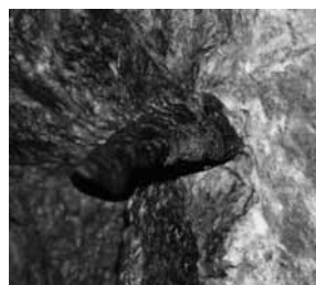
Die Sprenglöcher wurden von Hand gebohrt. Durch das abwechselungsweise Schlagen und Drehen des Bohrmeissels entstanden meistens drei- oder viereckige Löcher. Diese wurden ca. 1.5 m tief gebohrt und mit Schwarzpulver gefüllt.
