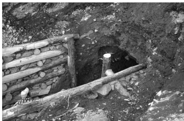
Figura 19. La costruzione dell'accesso e del portale della Miniera del Pozzo.
