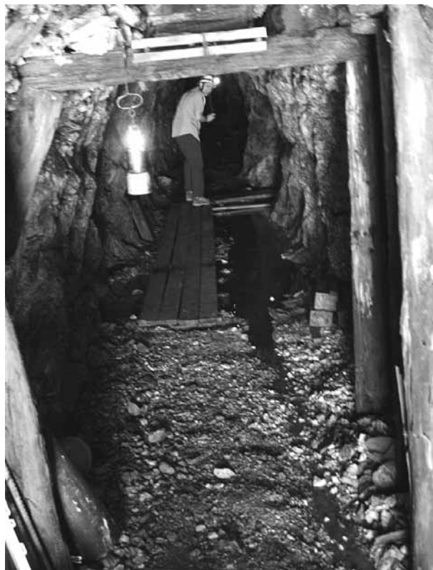
Die Sprenglöcher wurden von Hand gebohrt. Durch das abwechselungsweise Schlagen und Drehen des Bohrmeissels entstanden meistens drei- oder viereckige Löcher. Diese wurden ca. 1.5 m tief gebohrt und mit Schwarzpulver gefüllt.
